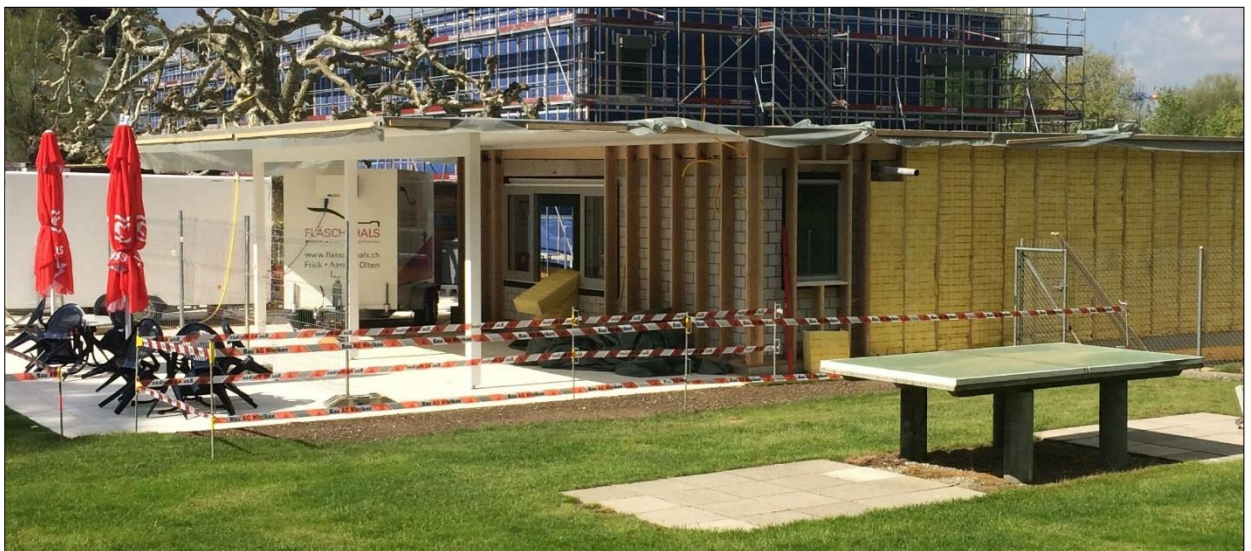
Verpflegungsbereich im Bau
