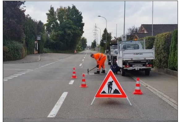
Baustellensicherung auf Strassen
