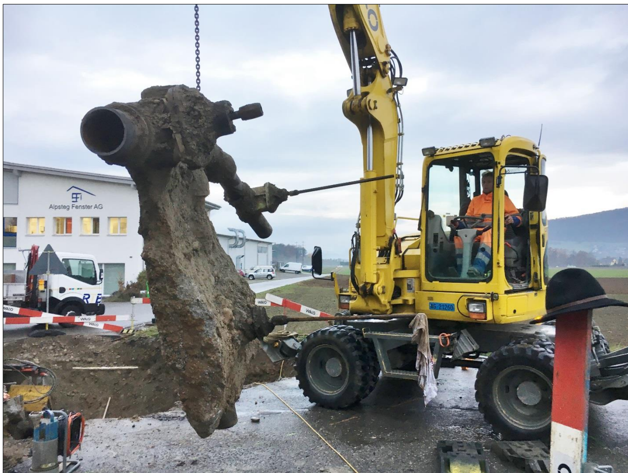
Rückbau des alten Schieberkreuzes Hardstrasse in Niederlenz
